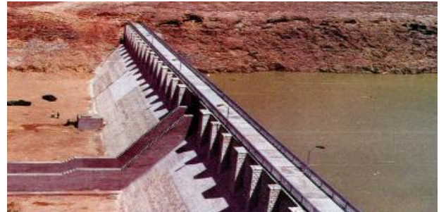
سد الكرم بمنطقة المغارة محافظة شمال سيناء
